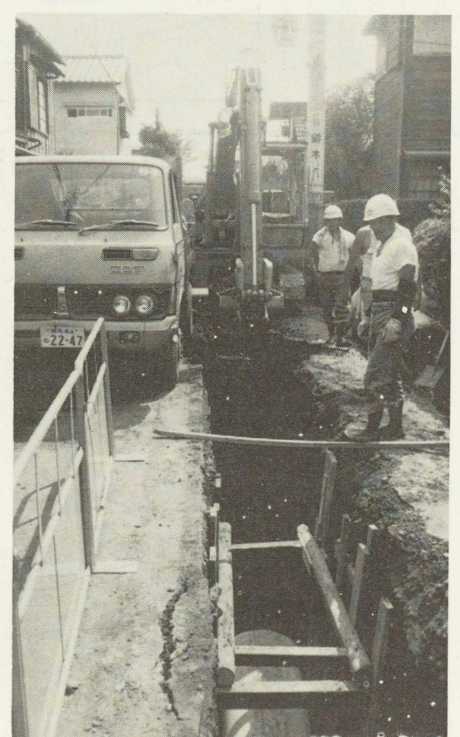
急ピッチで進む下水道工事
